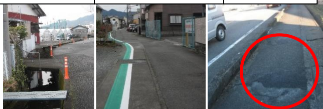
落下防止蛍光板 グリーンベルト塗直し 道路陥没補修
